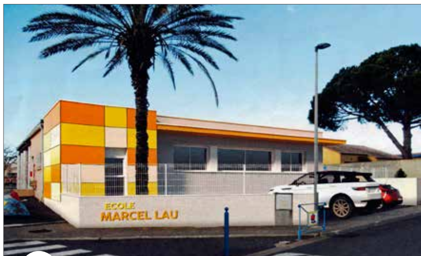
4 L'EXTENSION DE LA CANTINE SCOLAIRE
